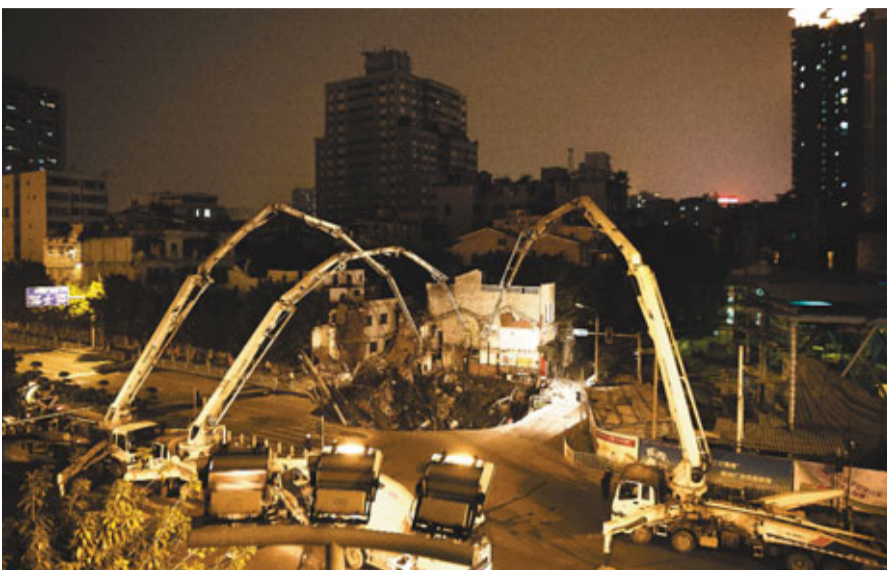
坍塌面積約300平方米、深約10米。現場可見多輛灌漿車正從吊臂中將泥漿灌入地底,填平空洞。 中新社
