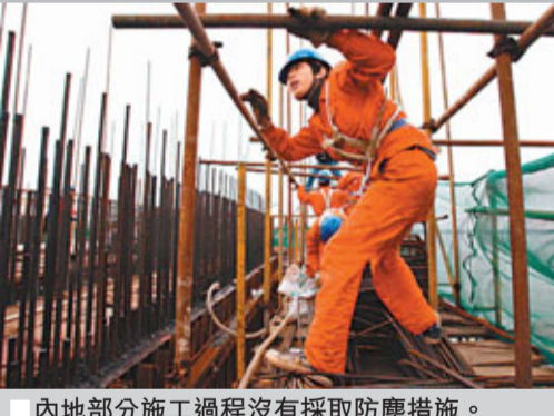
■ 內地部分施工過程沒有採取防塵措施。 資料圖片
