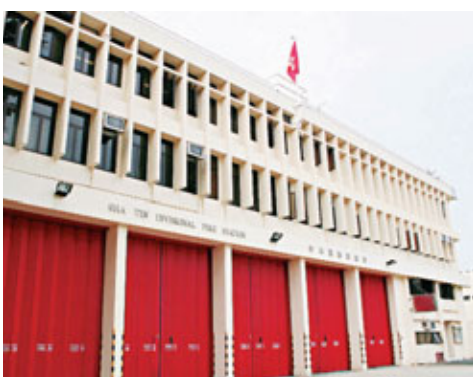
發生失竊的沙田消防局。
