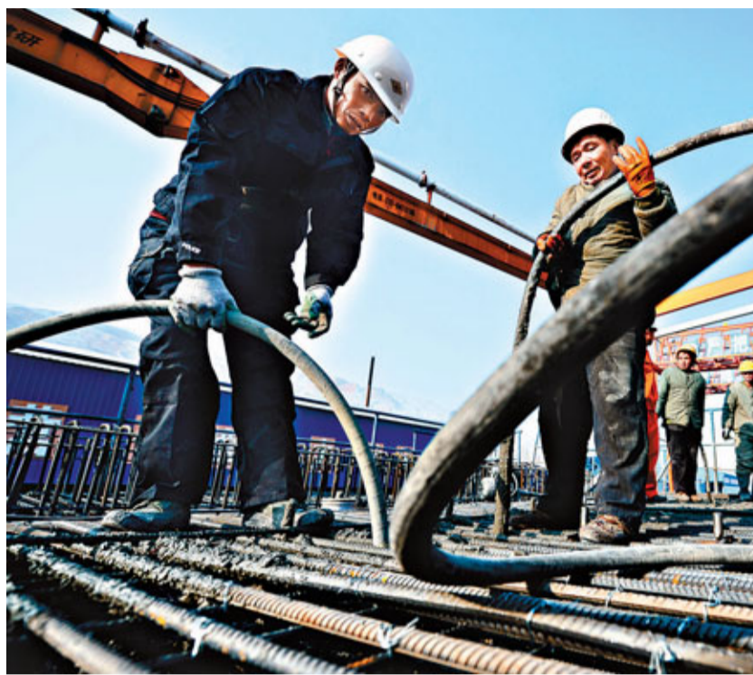
蘭新鐵路第二雙線青海段建設進展順利。圖為中鐵工人在箱樑澆築處作業。新華社
