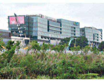
距離華僑濕地不到50米的歡樂海岸一期工程，還在繼續建設中。 李薇攝
