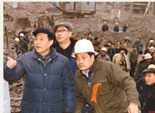
■鄭哲敏(左一)1984年在北京石景山電廠爆破拆除現場。 新華社
