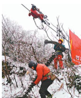
浙江省送變電工程公司電力工人在搶修電網。 新華社 組進駐浙江，指導浙江抗冰搶險工作；同時，從四川省電力公司、安徽省電力公司調集的融冰等相關裝置正緊急運往浙江。截至10日13時，浙江電網因雨雪冰凍受損的500千伏線路已全部修復供電。
