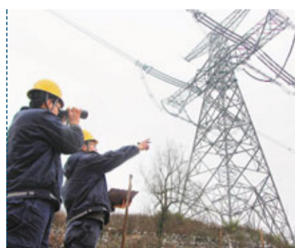
■重慶加強巡線，確保電力安全運行。
