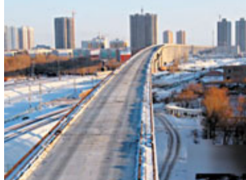
已架設完成的「蘭新鐵路」新疆哈密特大橋。 網上圖片
