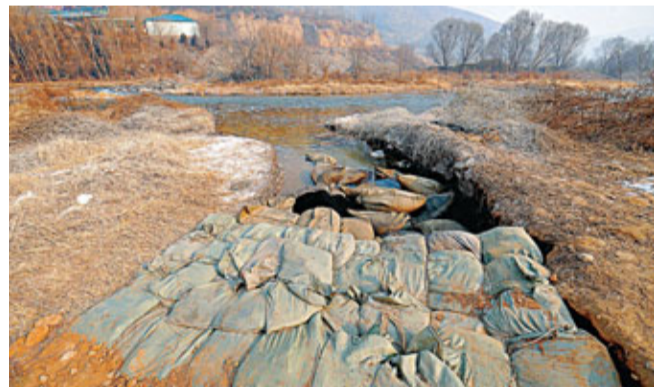
■洩漏苯胺的排污渠河口處已用活性炭築起了一道「破壩」，防止污染物繼續污染河水。 新華社
