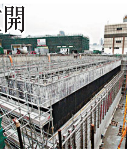
昂船洲污水處理廠建造一個全球一級污水處理中最大的地下泵房。梁祖彝攝
