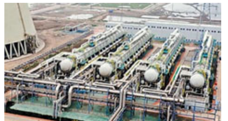
■濱海北疆發電廠循環經濟項目海水製鹽—土地節約整理—廢物資源化再利用的「五位一體」循環經濟模式。
