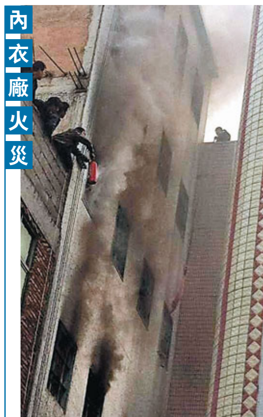
■廣東汕頭潮南區陳店鎮洋新村一家內衣廠19日下午發生火災，傷亡不明。據現場目擊者介紹，現場濃煙滾滾，大量消防車和救護車在現場救援。目前，有否受傷人員及事故原因正在調查中。
