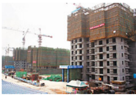
發改委建議,要允許農民參與保障房建設。圖為陝西保障房建設項目施工現場。資料圖片
