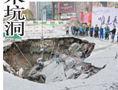
■ 施工人員正在對地陷處進行清理。
