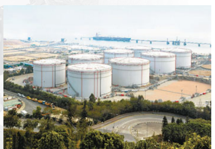
屯門航空油庫儲存設施
