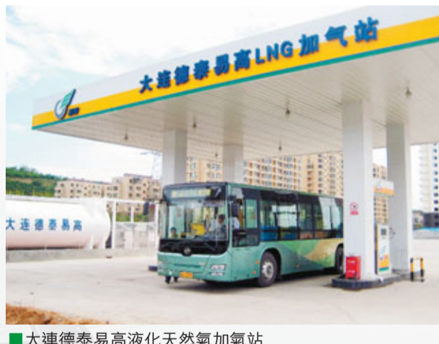
大連德泰易高液化天然氣加氣站
