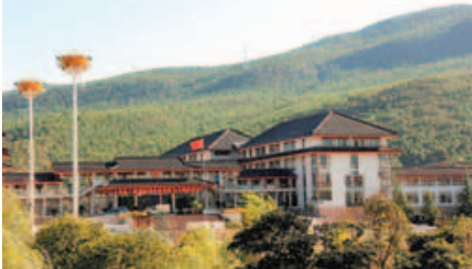
■玉龍新縣城基礎設施利用坡地建設而成
