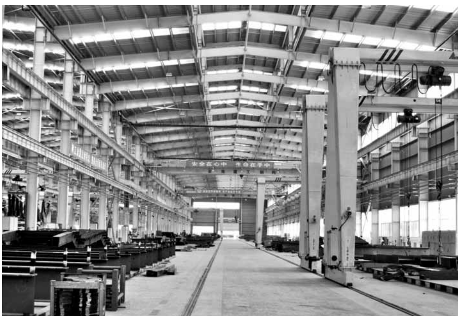
■新型工業化催生昆明新興產業。圖為楊林工業園區建工鋼構生產車間一角。
