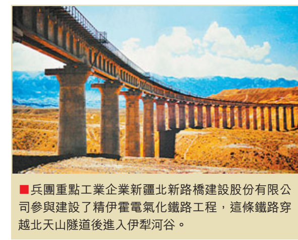
■兵團重點工業企業新疆北新路橋建設股份有限公司參與建設了精伊霍電氣化鐵路工程，這條鐵路穿越北天山隧道後進入伊犁河谷。
