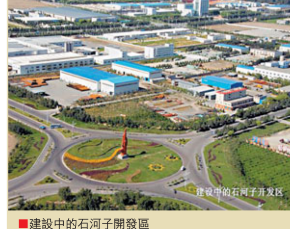
■建設中的石河子開發區
