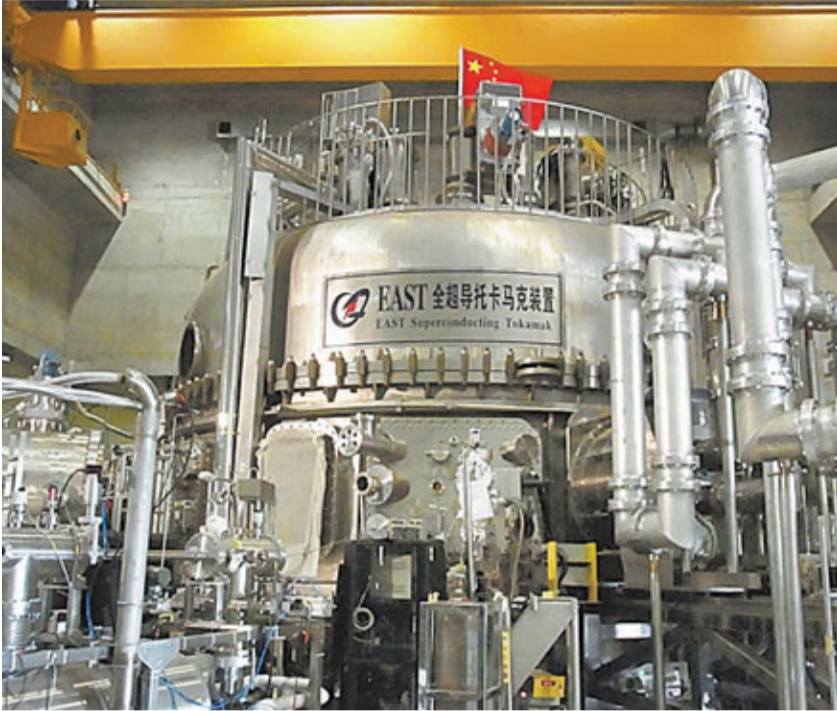
■中科院合肥物質科學研究院的全超導托卡馬克裝置，是中國自行設計研製、全球首個全超導托卡馬克核聚變實驗裝置。
