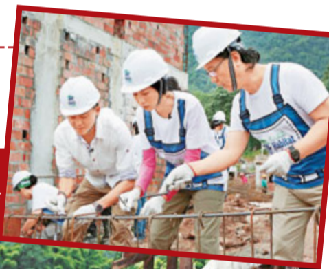
莫文蔚與衛志豪落手落腳紮鋼筋。
