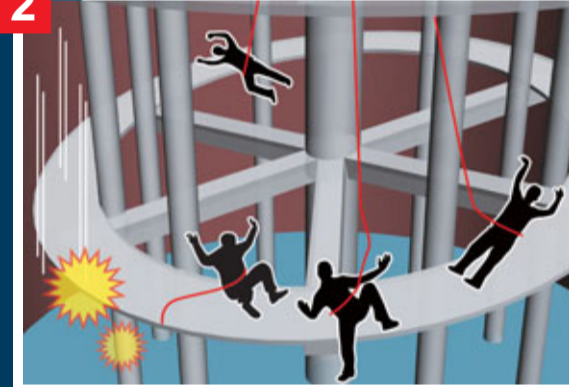
工作台突傾側下墜2米，工人如坐「跳樓機」般被拋起，幸各人佩戴安全帶，未致跌落鳥籠底水中。
