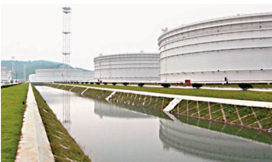
中國能源儲備規模較小，應急能力相對較弱，能源安全形勢嚴峻。圖為浙江舟山國家石油儲備基地。資料圖片
