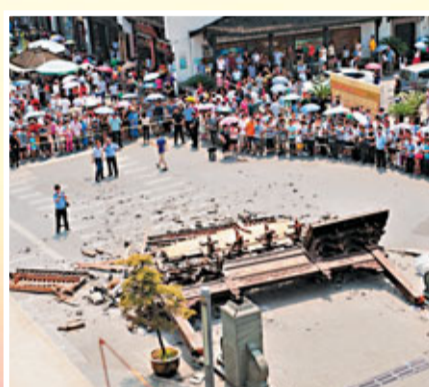
河坊街仿古牌坊倒塌造成兩死一傷。
