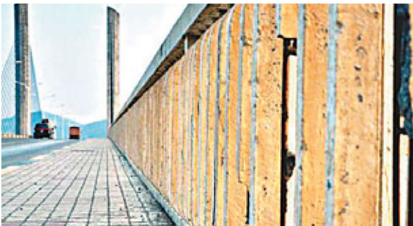
■橫琴大橋橋面護欄有多處已裸露出鋼筋。
