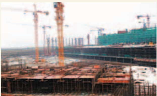
■橫琴的各項基礎設施，正在快速建設。
