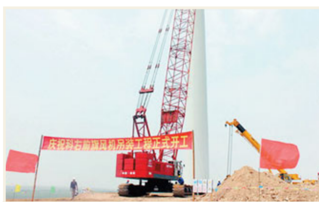
■大唐興安盟科右前旗一期風電項吊裝工程啟動。
