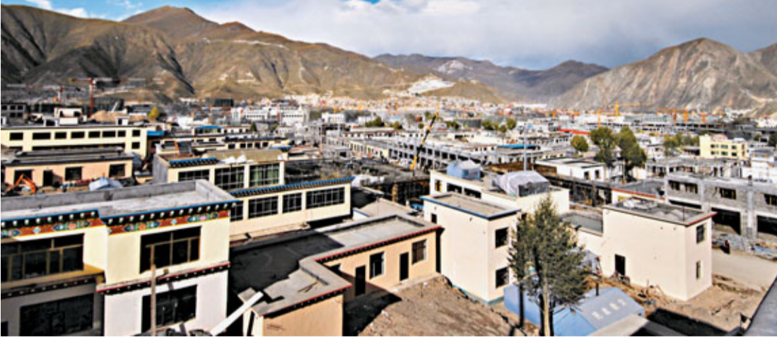
近日,青海省玉樹藏族自治州扎西大同村400多戶災區農牧民陸續搬進新居,告別救災帳篷。據了解,玉樹地震災後重建工作開展至今,共有39060戶住宅開工,陸續交付使用。
