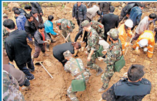
■武警昭通支隊官兵和駐地群眾一起在彝良山體滑坡現場挖掘被壓埋的人員。
