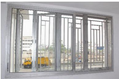
■雙層設計的「隔音窗」，外層可向外開啟，內層則是趟窗，兩層中間鋪設吸音物料，有效隔音。
