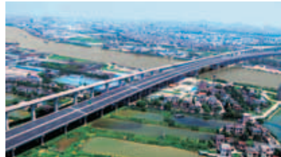
珠江三角洲西岸幹道
