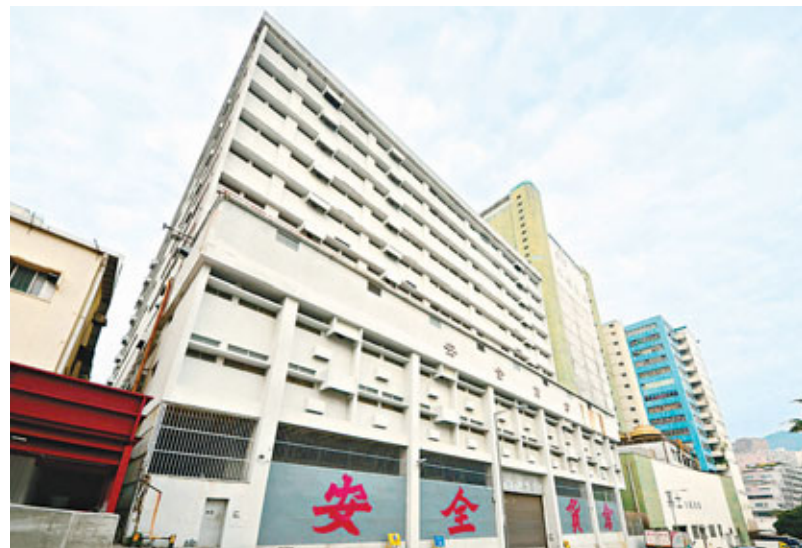
擁有重建住宅潛力的荃灣國瑞路安全貨倉推出招標,預計售價12億元。
