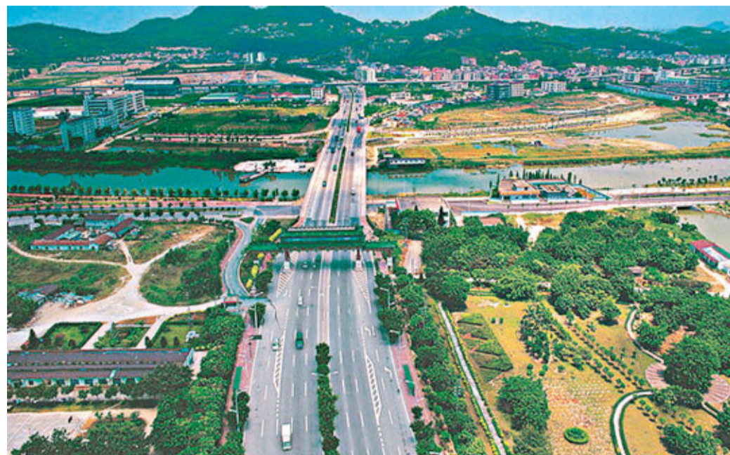
■廣州南沙新區規劃已獲國務院批覆。圖為南沙全景。
