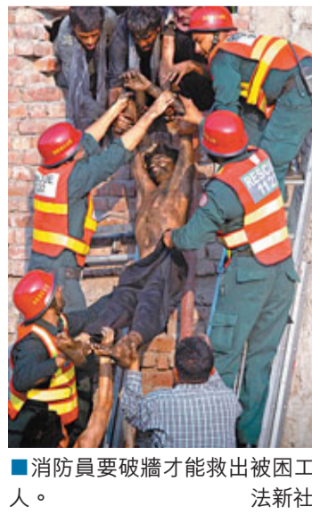
消防員要破牆才能救出被困工人。
