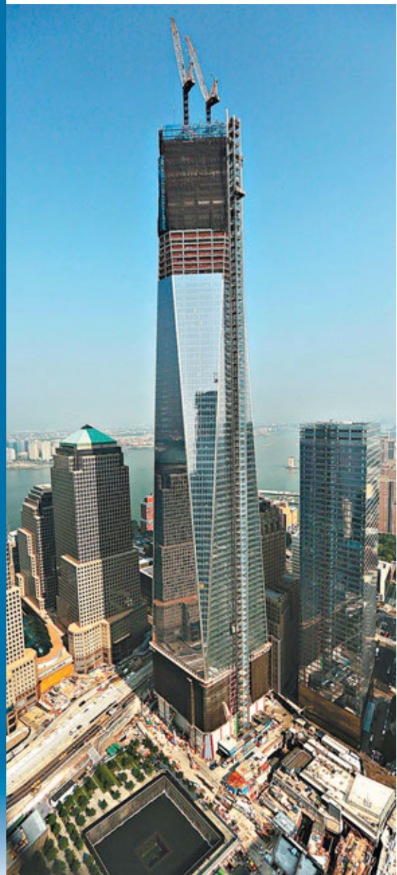
正在興建的世貿中心一號大樓。
