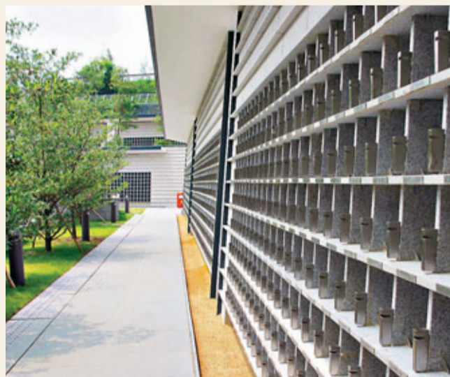
和合石橋頭路靈灰安置所提供8,400個室外靈灰龕位。
