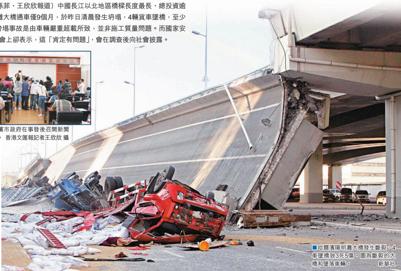
哈爾濱陽明灘大橋發生斷裂，4車墜橋致3死5傷。圖為斷裂的大橋和墜落車輛。新華社
