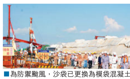
為防禦颱風，沙袋已更換為模袋混凝土保護島壁。
