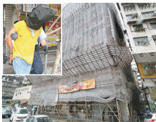
譚公道遭飛賊爆竊大廈正進行翻新工程。小圖為潛入住宅爆竊事敗被擒疑犯。
