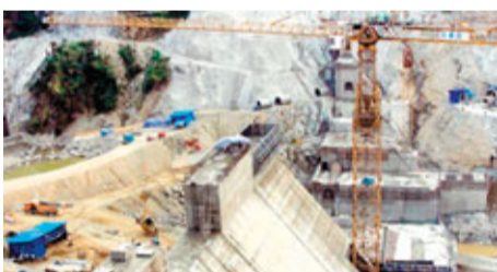
中國承建的密松大壩施工地。網上圖片
