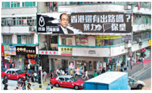
馮檢基大型廣告牌被屋宇署證實屬於違例建築。資料圖片
