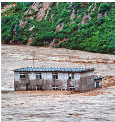
受颱風影響，瀋丹高速遼寧本溪南芬段兩側房屋被洪水浸泡。新華社
