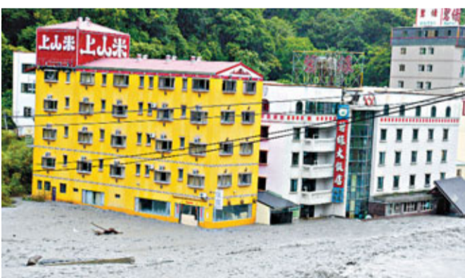
台灣廬山溫泉吊橋下游溪旁多家溫泉旅館淹水。中央社
