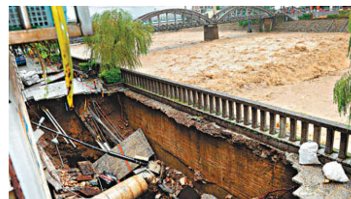
新北市三峽區三峽河暴漲，導致路面塌陷。中央社
