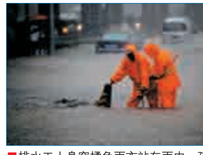
■排水工人身穿橘色雨衣站在雨中，疏通堵塞的下水道。
