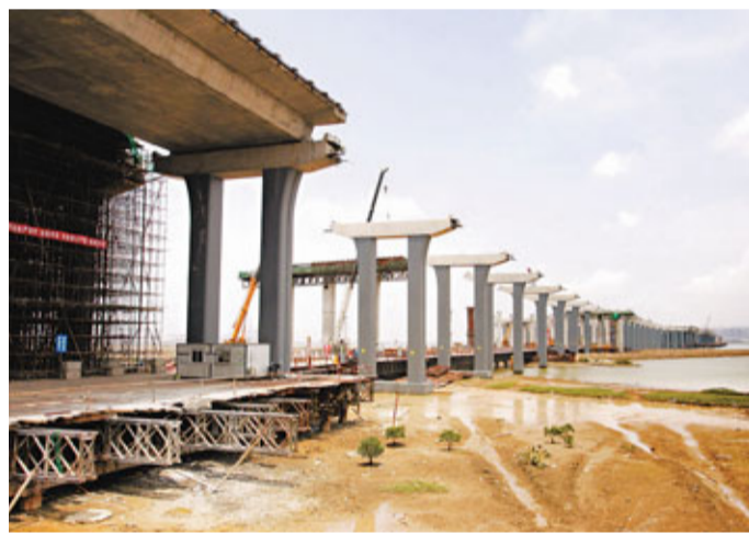
廣深沿江高速公路深圳段有望在2013年6月底前建成通車。圖為建設中的廣深沿江高速公路深圳段。
