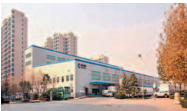
■公司承建的鄭州煙草集團恒溫煙草物流庫項目
