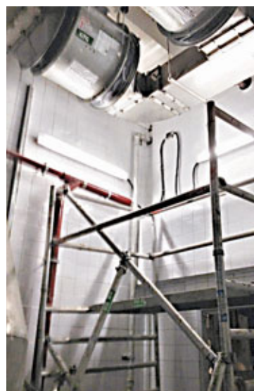
■泥水工觸電時所站的鐵架工作台上，牆身有光管及多條電纜。
