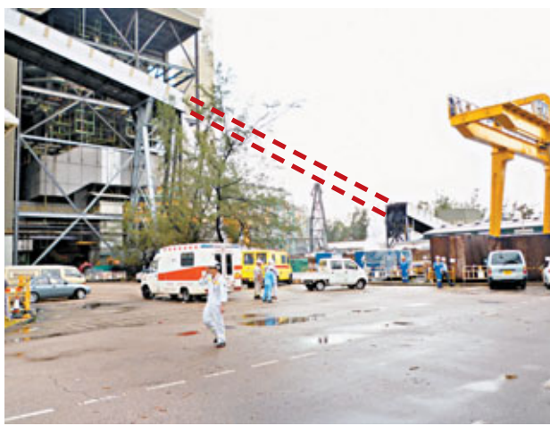
■發電廠長達50米的運煤帶組件(虛線)整節坍塌，幸未釀成傷亡。
