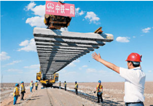
■哈羅鐵路全線鋪通。圖為施工指揮員在指揮鋪設軌排。新華社
