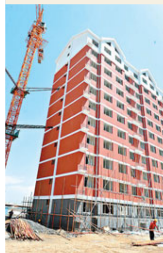
寧夏銀川一處保障性住房建設工地。新華社
