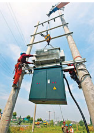
■浙江省湖州電力局施工人員正在對東林鎮泉慶村變壓器進行升級改造，保證夏季高峰用電。 新華社
